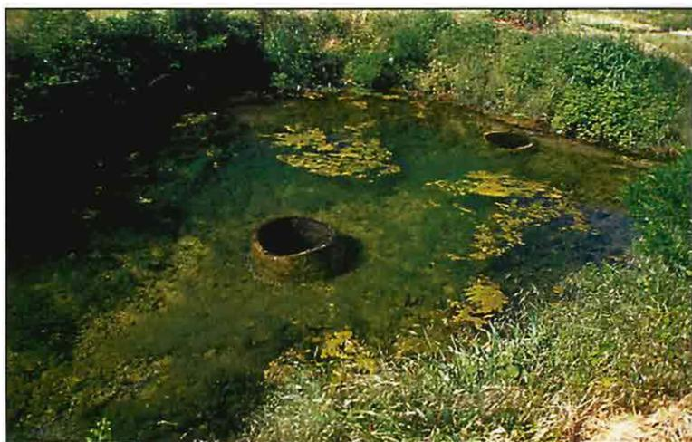
Foto 1.3: Fontanone di Torlino, sono evidenti i tini in cemento posizionati per favorire la risalita delle acque sorgive.
